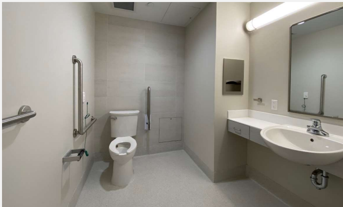
Vista del baño privado adosado al modelo de la habitación para residente
