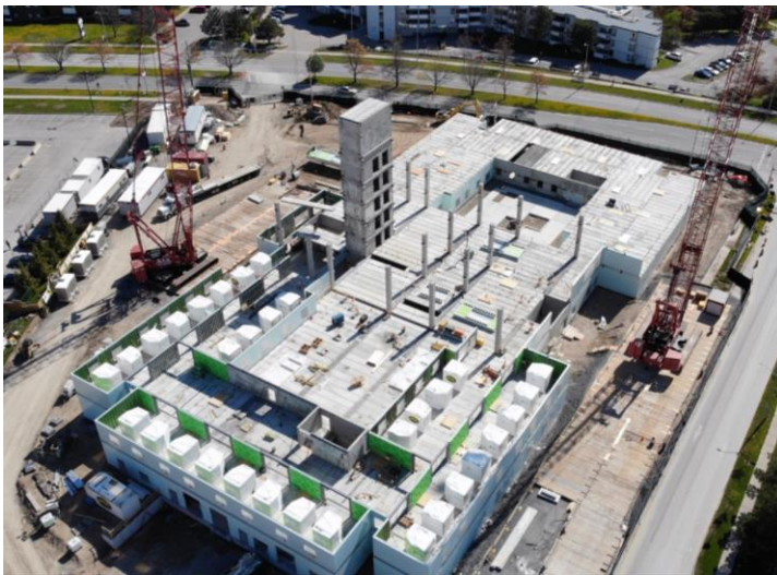
تصویر تکمیل شده محور آسانسورها و قسمتی از تکمیل طبقه دوم و 32 اتاقک توالیت در 8 ماه مه 2021
