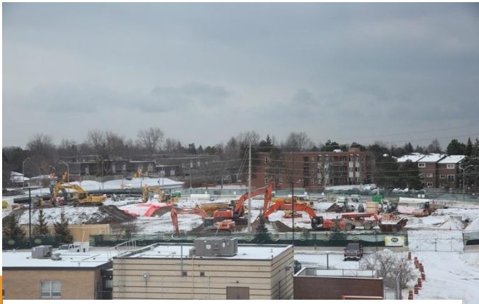
நீண்டகாலப் பராமரிப்பு இல்லக் கட்டுமானம் - பெப்ரவரி 2021
