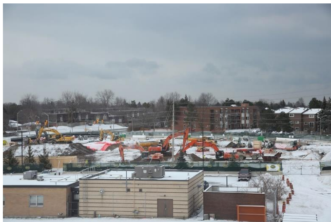
Construction du centre de soins de longue durée — Février 2021
