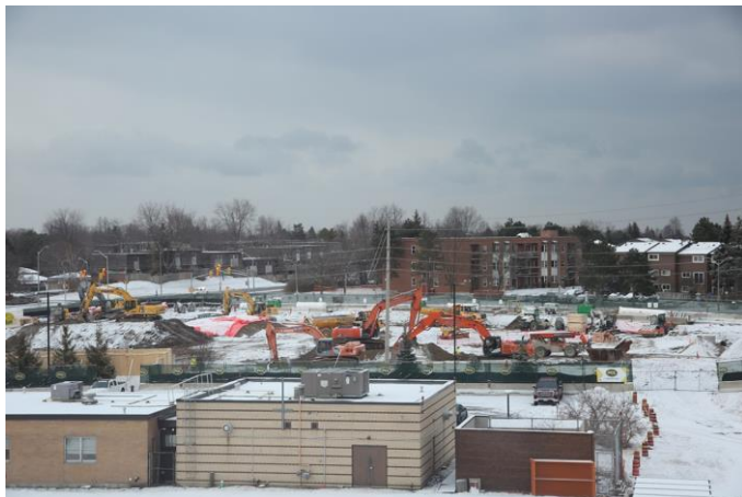
Construcción del centro de atención de enfermos crónicos; febrero de 2021
