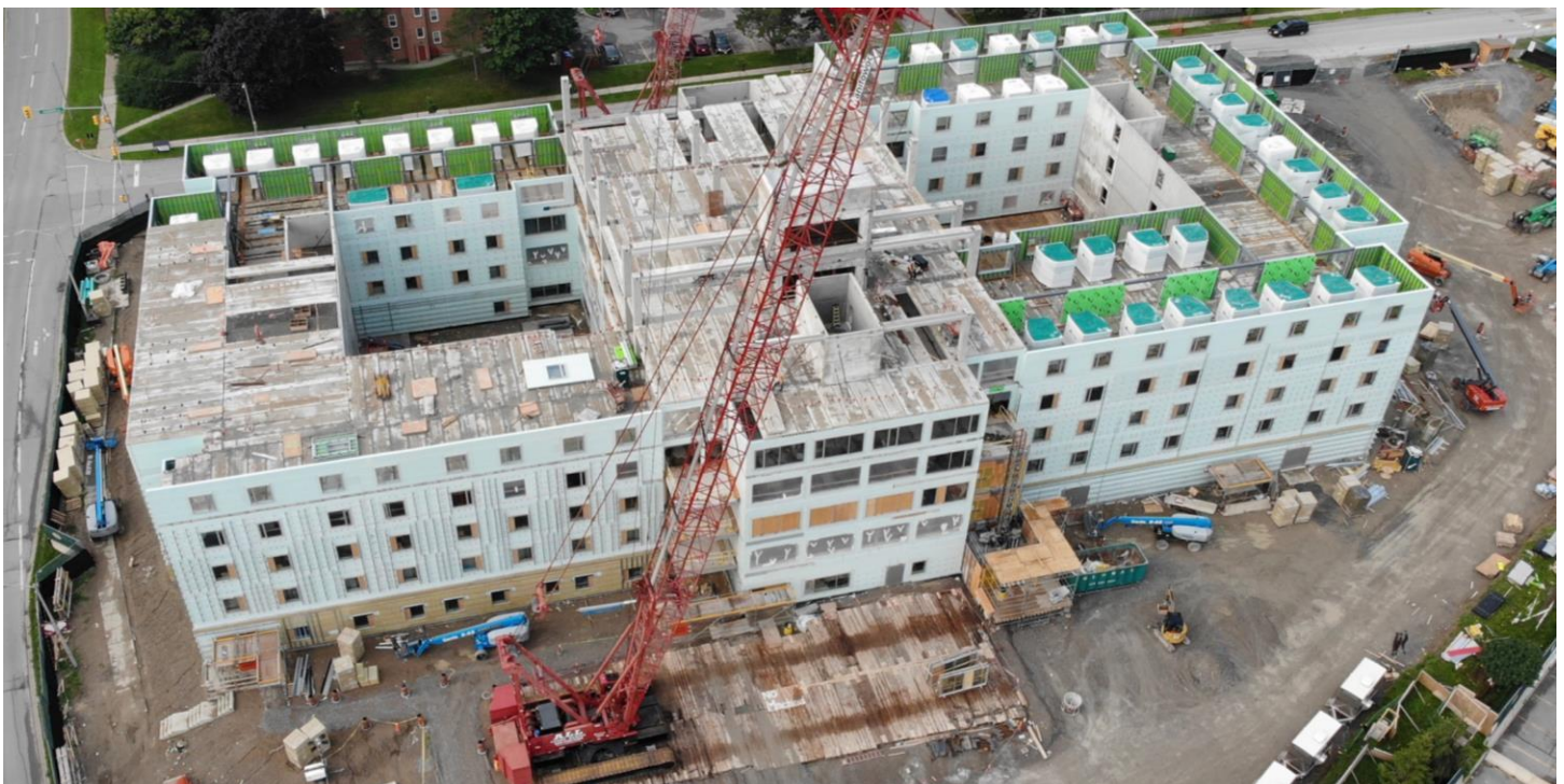
Des équipes travaillant au sixième étage le 17 juillet 2021
