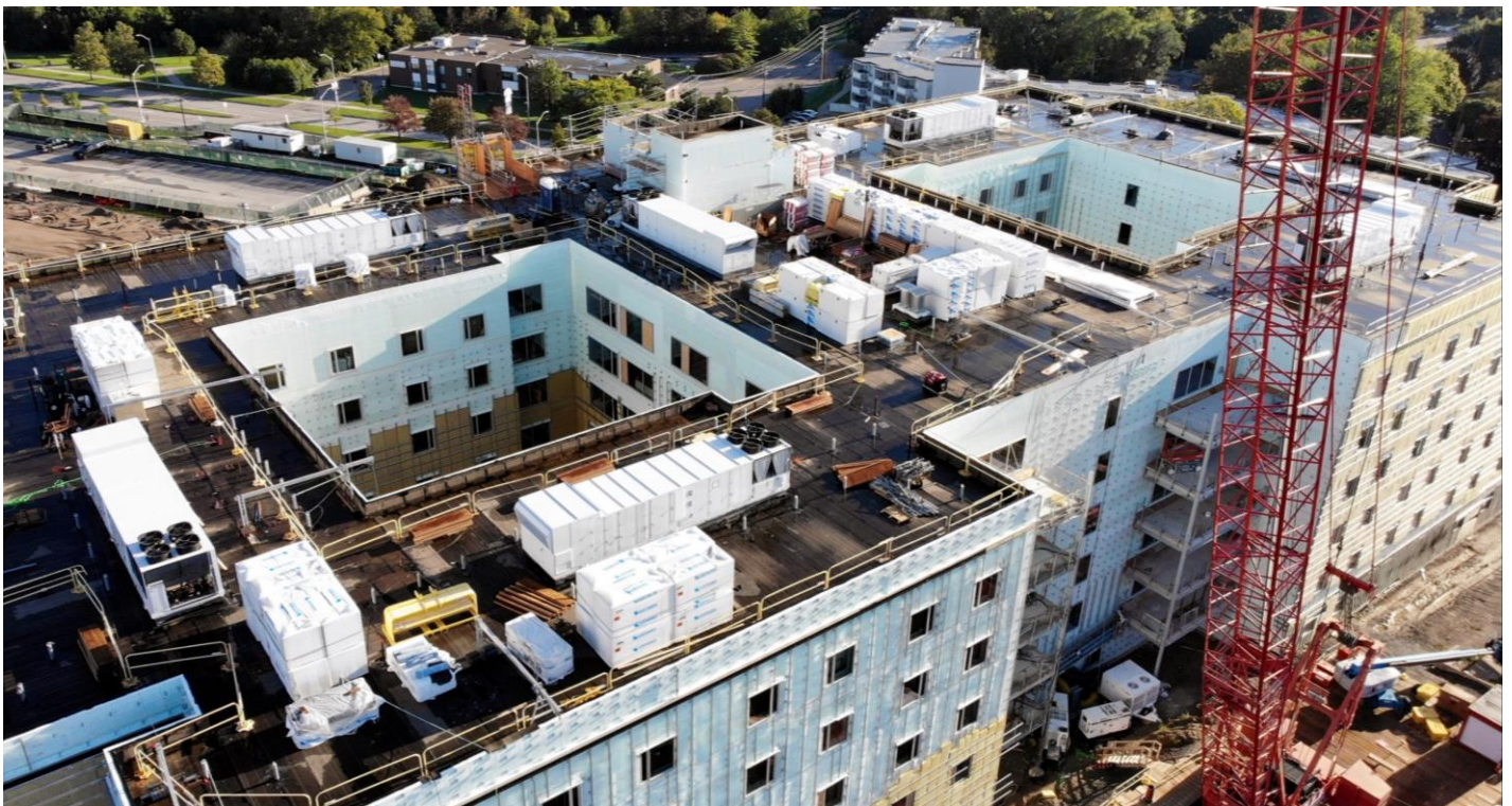
Un aperçu du toit du foyer en date du 26 septembre 2021
