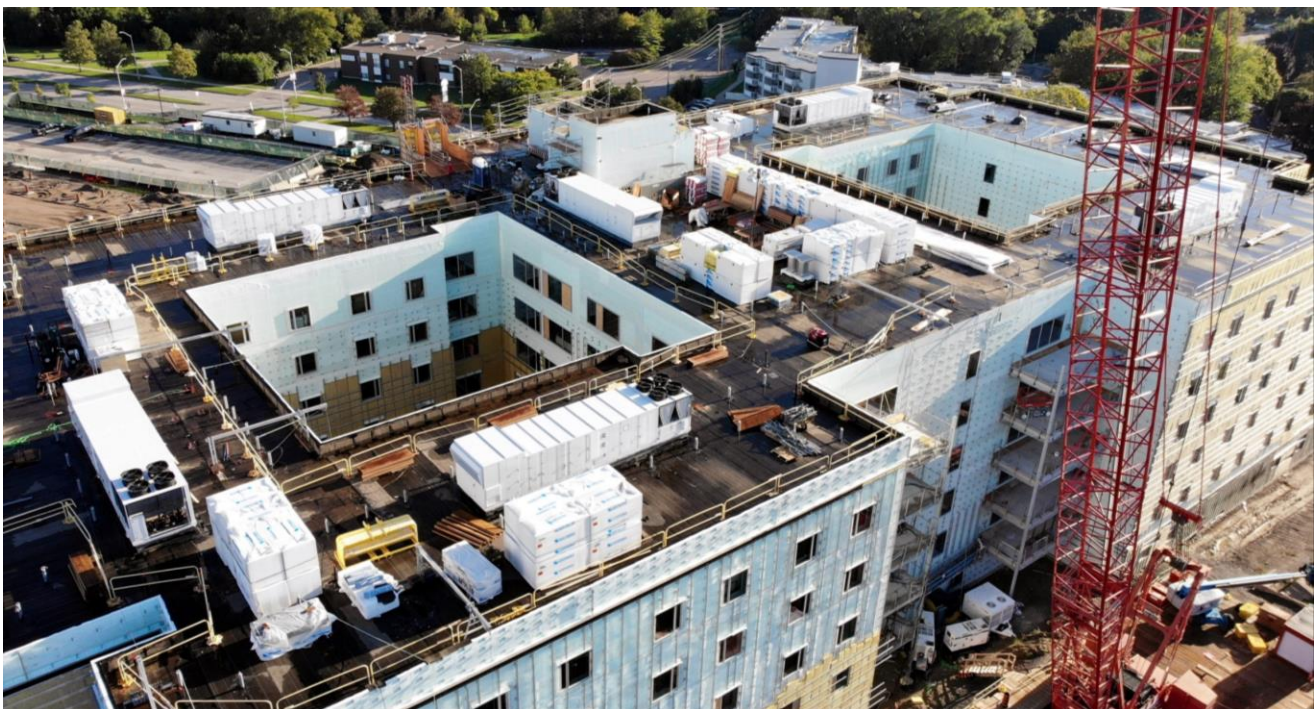
Vista del tejado del centro el 26 de septiembre de 2021
