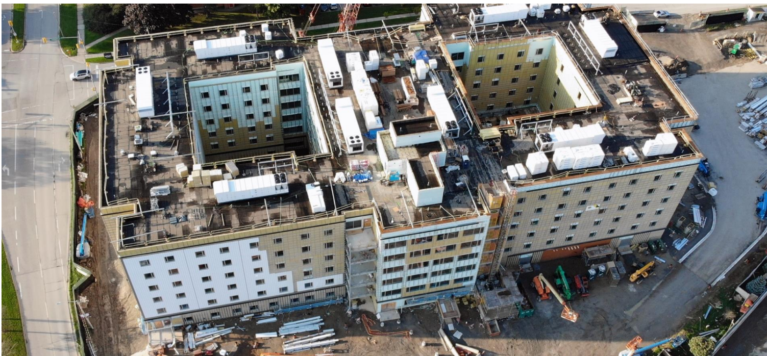
Vista del nuevo revestimiento exterior del lado Norte del edificio (11 de octubre de 2021)
