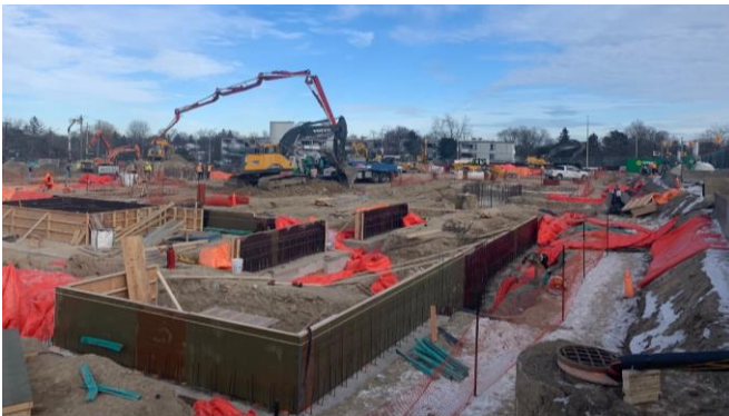
Obra en los cimientos el 9 febrero de 2021.
