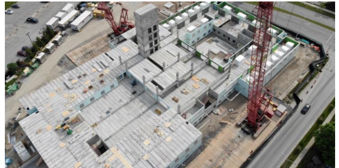
Tercer piso casi terminado, el 21 de mayo de 2021
