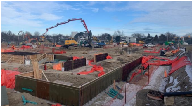
修筑地基，2021 年 2 月 9 日
