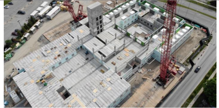
Le troisième étage partiellement achevé le 21 mai 2021.
