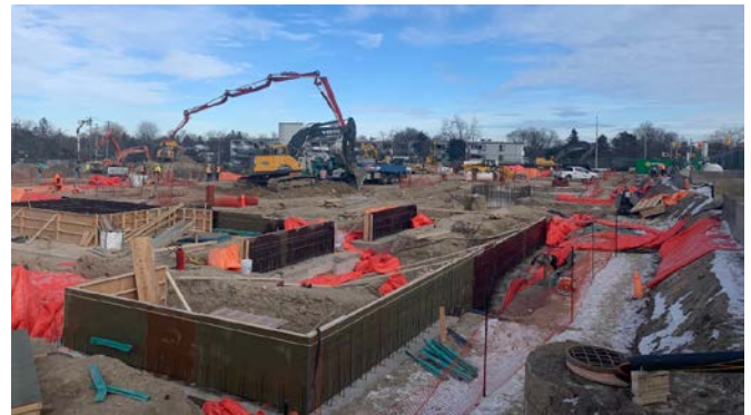
کار روی فونداسیون در 9 فوریه 2021
