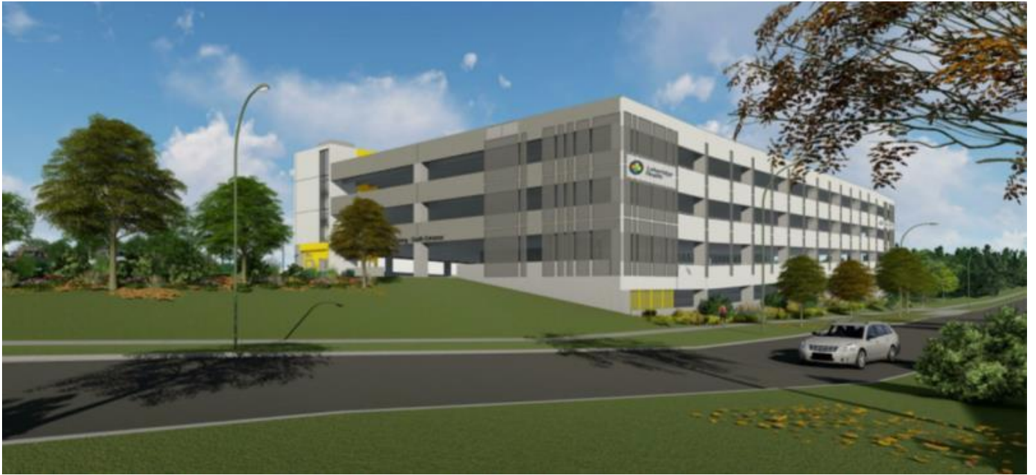
ارٹسٹ کا ہسپتال اور طویل مدتی نگہداشت کے عملے ، رہائشیوں اور ملاقاتیوں کے لئے +500 کار پارکنگ گیاراج دکھانا
