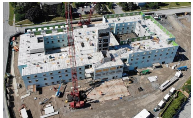
Equipos trabajando en el cuarto piso el 19 de junio de 2021
