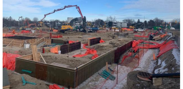
2021 年 2 月 9 日修筑地基
