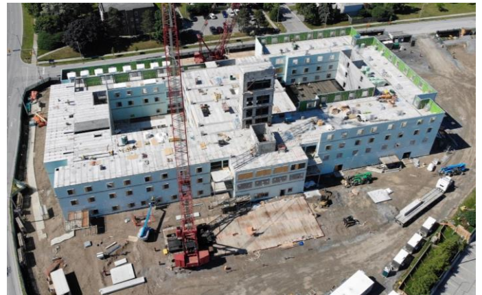
2021 年 6 月 19 日，工作人员在四楼施工
