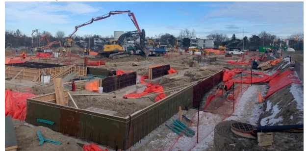
Travaux de pose des fondations (9 février 2021)
